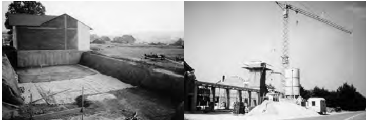
Baugrube und Rohbau im Jahre 1987
