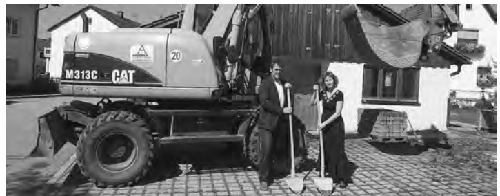
Der ersten Spatenstich von Frau Pfn Nun und Herrn Architekt Rieger. Werner Langenberger
