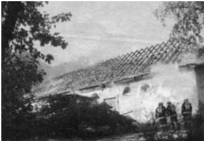
Als die Einsatzkräfte vor Ort eintrafen, stand das Dach des „Fürstenstalls“ bereits in Flammen. Foto: Christelli
